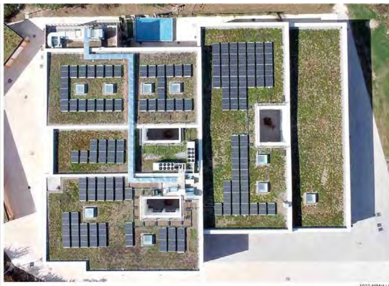
▲ Tetto verde La copertura è a tetto verde estensivo per garantire drenaggio e invarianza idraulica. Nessun albero è stato tagliato sul lotto e ne verranno aggiunti circa 50 nuovi
