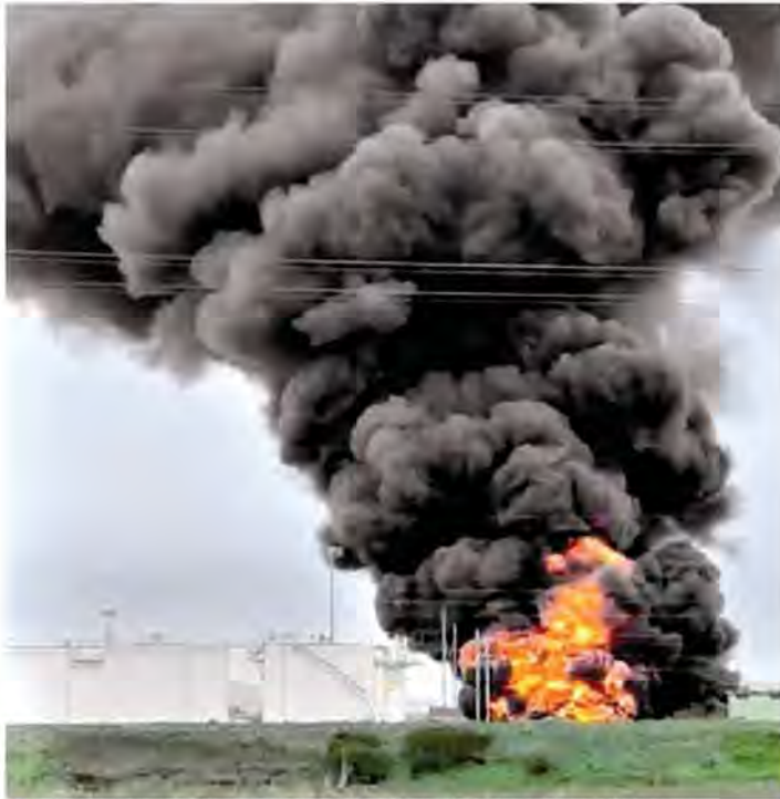
Explosione Le fiamme divampano davanti alla raffineria dell'Eni nel comune di Calenzano
