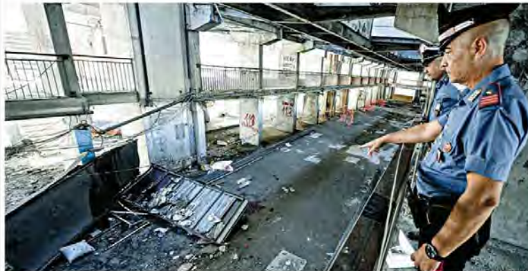
Il crollo. Un sopralluogo all'interno della Vela Celeste, a Scampia, dove ha ceduto un ballatoio
